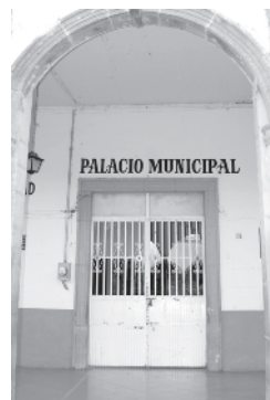
Fachada de la entrada principal del Palacio Municipal de Yurécuaro.
